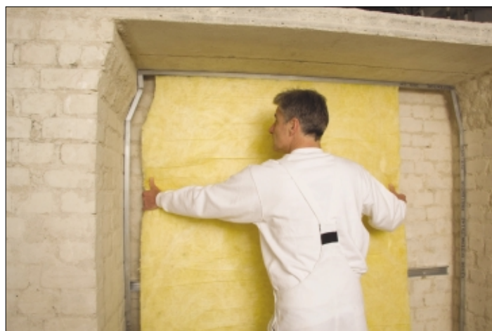
(pb) Bei vielen Gebäuden hilft eine Innendämmung beim Energiesparen. Foto: Fachverband Mineralwolleindustrie e.V.
